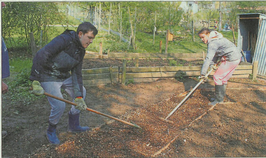
Zu den Aufgaben gehörte unter anderem, einen Weg über das Gelände zu bauen.
